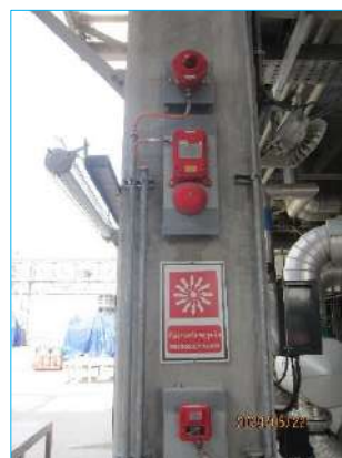
ภาพที่ 2-45 สัญญาณเตือนเพลิงไหม้ (Fire Alarm Manual System)
