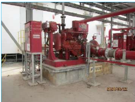
ภาพที่ 2-67 เครื่องสูบน้ำดับเพลิงประเภทขับเคลื่อนด้วยเครื่องยนต์ดีเซล
