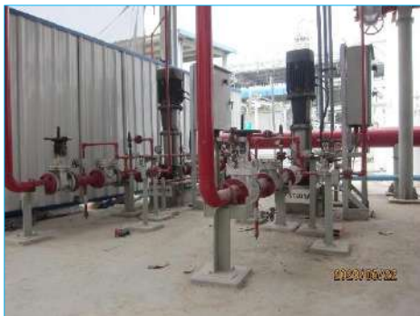
ภาพที่ 2-65 เครื่องสูบน้ำรักษาแรงดัน (Jockey Pump)
