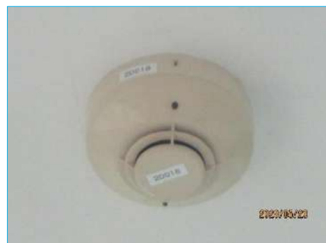
ภาพที่ 2-70 อุปกรณ์ตรวจจับควัน (Smoke Detector)
