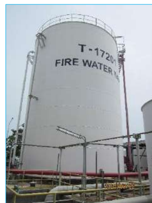
ภาพที่ 2-68 ถังเก็บน้ำสำรองดับเพลิง
