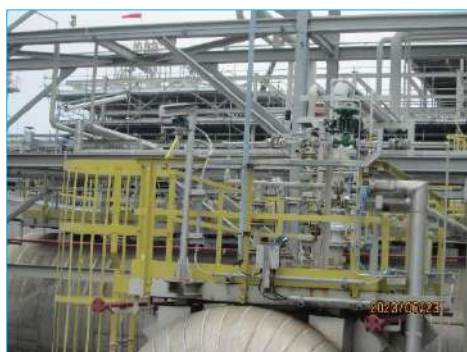
ภาพที่ 2- 59 ระบบก๊าซไนโตรเจน (Nitrogen Blanketing) บริเวณถังเก็บกาก
