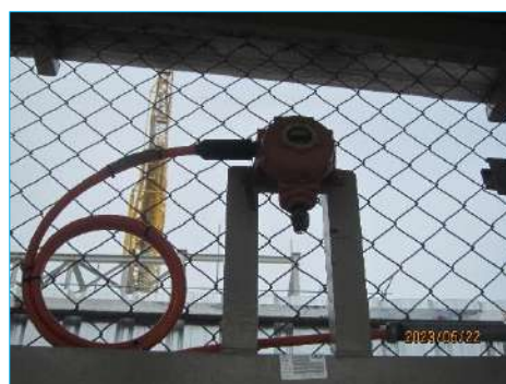
ภาพที่ 2-10 Gas Detector ตรวจสอบการรั่วไหลของสารแอมโมเนียไฮไดรด์
