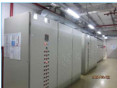
ภาพที่ 2-8 ระบบไฟสำรองแบบยูพีเอส (UPS)
