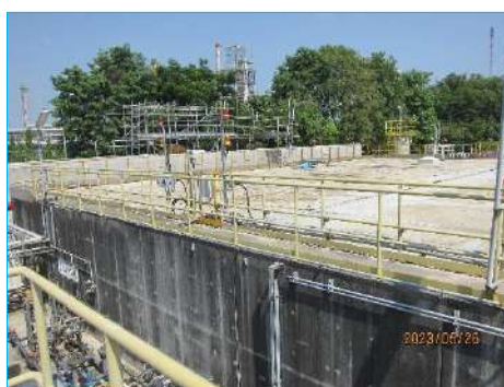
ภาพที่ 2-16 บ่อพักน้ำเสีย (Surge Basin) (Z-18209B, Z-18209D และ Z-18209C)
