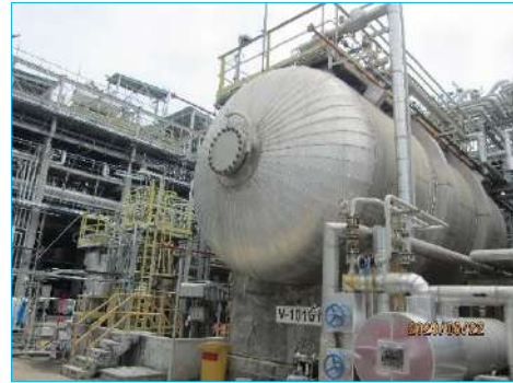
ภาพที่ 2-64 ถังเก็บ 1,3-บิวทาไดอินที่มีฉนวนหุ้ม
