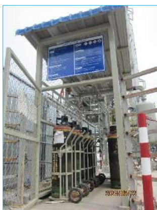
ภาพที่ 2-10 Gas Detector ตรวจสอบการรั่วไหลของสารแอมโมเนียไฮไดรด์
