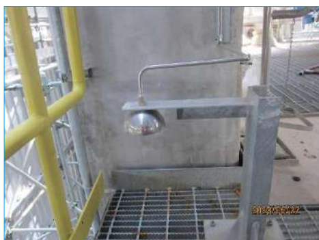
ภาพที่ 2-49 Gas Monitoring System
