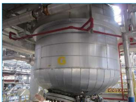
ภาพที่ 2-53 ระบบการพ่นน้ำลงบนถังปฏิกริยา (Reactor)
