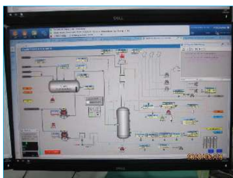
ภาพที่ 2-6 ระบบควบคุมการทำงานของหอเผา
