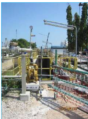
ภาพที่ 2-15 บ่อรองรับน้ำฝนปนเปื้อน (Rainwater Pond)
