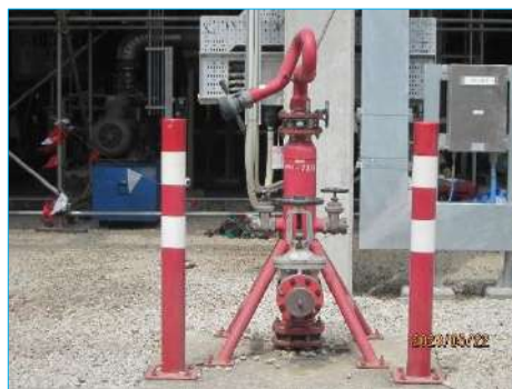
ภาพที่ 2-56 หัวจ่ายน้ำดับเพลิง (Firewater Monitor)
