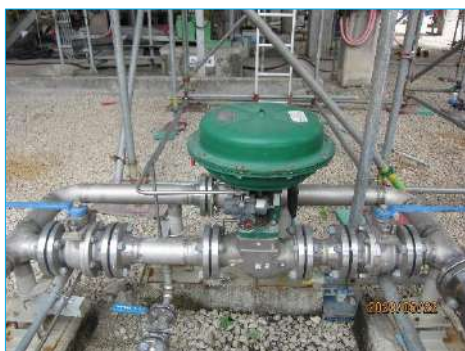
ภาพที่ 2-2 ระบบวาล์วควบคุม (Control Valves)
