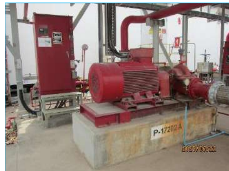
ภาพที่ 2-66 เครื่องสูบน้ำดับเพลิงประเภทขับเคลื่อนด้วยมอเตอร์ไฟฟ้า
