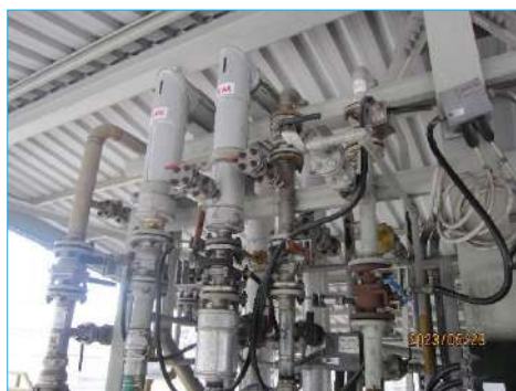
ภาพที่ 2-61 วาล์วควบคุมบริเวณแนวท่อขนส่งวัตถุดิบ
